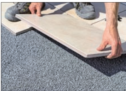
Schnelle Verlegung von KeraCeram spart Zeit und Geld
