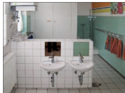
Vorher: Die Sanitärräume der Kita Apfelbäumchen
